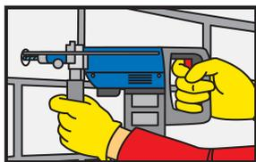
1. Praticare il foro, con diametro e profondità richiesti, con il trapano. Il diametro del foro e la barra d'ancoraggio devono in ogni caso corrispondere.
